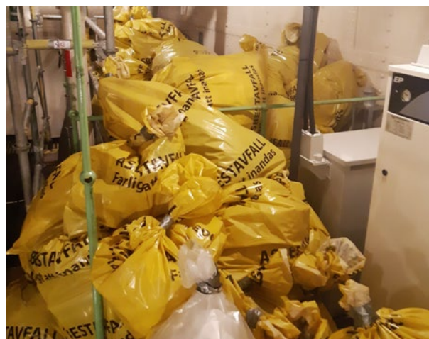
På ett par av SMTM:s museifartyg har asbestsanering pågått under året. Säckarna på bilden är asbestavfall från sanering på museifartyget Sankt Erik. Foto: Ola Dahlqvist, SMTM.
